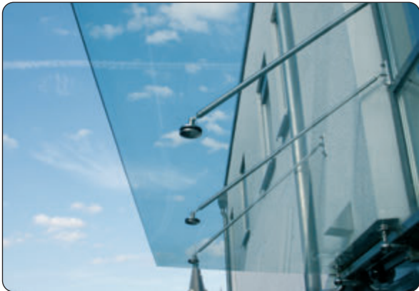
Verbaut an einem Mehrfamilienhaus in Gummersbach
